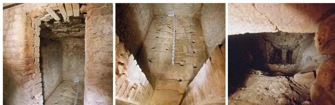
Röhrenhütte Ofen C. Blick durch die Einsetzöffnung in den Brennraum und auf die Lochtenne. Beim Brand wird die Einsetzöffnung zugemauert. Die Lochtenne hat Zuglöcher, die die Verbindung zum darunterliegenden Feuerungsraum herstellen. Rechts: Blick von Osten in die Einfeuerung. Im Hintergrund die Reparaturstütze unter der Lochtenne (Fotos Alex Ueltschi, ADB).
